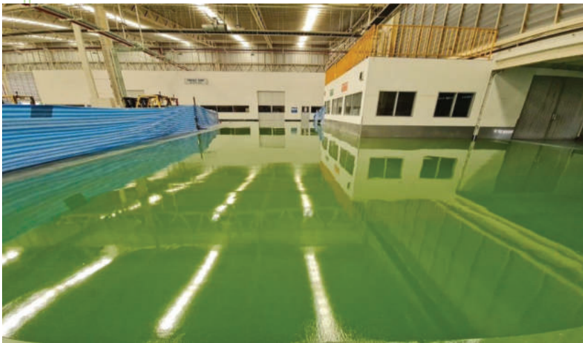
2.งานเคลือบพื้นผิว PU MF ชนิดกึ่งเงา 5mm. 750 ตรม.
