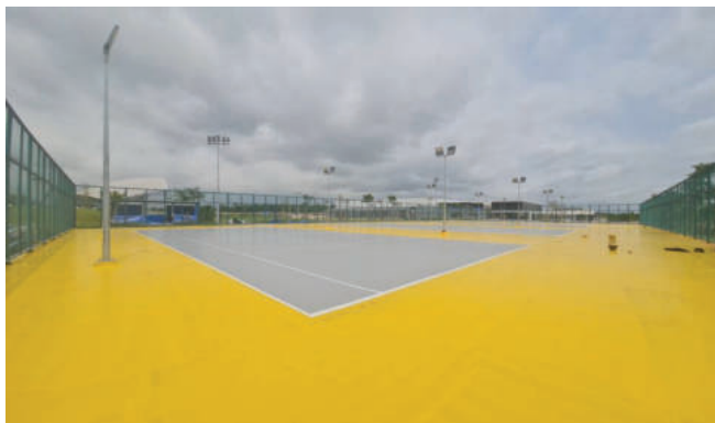
5.งานพื้นยางสยวมเทนนิสระบบโพรียูรีเทน ความหนา 5mm. พื้นที่ 3,000 ตร.ม. หน่วยงาน ปตท.ระยอง
