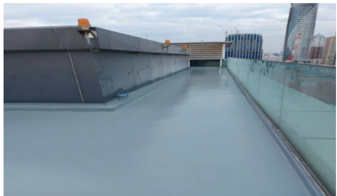
งานกันซึมดาดฟ้าระบบโพรียูรีเทน 3 mm. 1,300 ตรม. สำนักงานตำรวจแห่งชาติ
