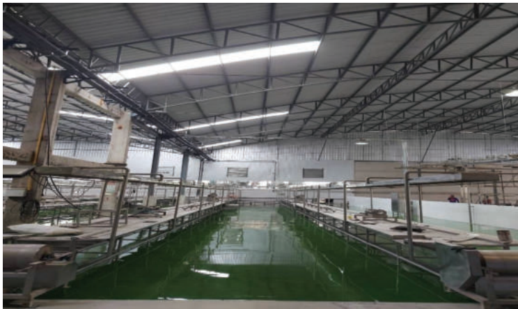
งานเคลือบพื้นผิว PU MF 4mm.1500 ตรม. บริษัท ไทยยอดทิพย์จำกัด สามร้อยยอด
