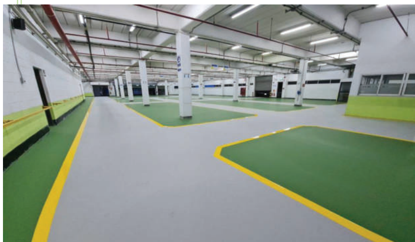
3.งานเคลือบพื้นผิว PU MF 4mm. 756 ตรม.
