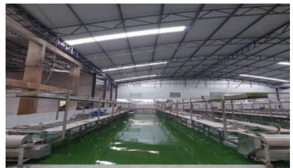
งานเคลือบพื้นผิว PU MF 4mm.1500 ตรม. บริษัท ไทยยอดทิพย์จำกัด สามร้อยยอด
