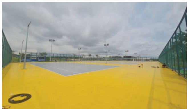
5.งานพื้นยางสยวมเทนนิสระบบโพรียูรีเทน ความหนา 5mm. พื้นที่ 3,000 ตร.ม. หน่วยงาน ปตท.ระยอง
