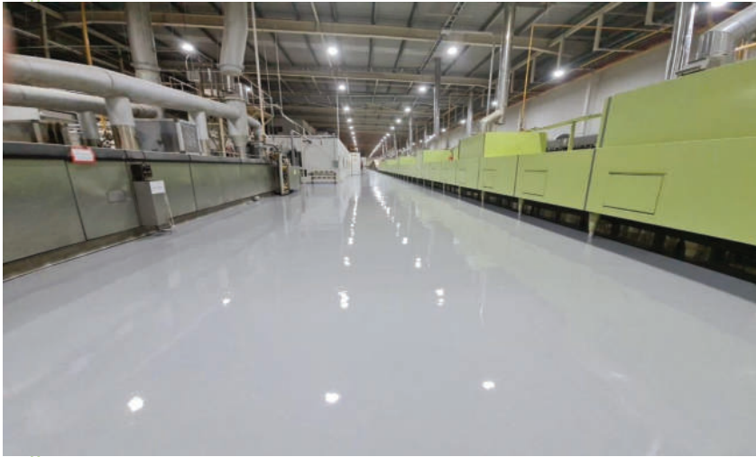
1.งานเคลือบพื้นผิว PU MF 4mm. บริษัท นิชชิน (ไทยแลนด์) นิคมอุตสาหกรรมอมตะซิตี้
