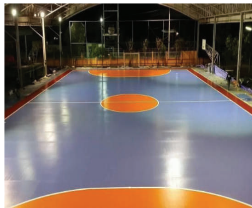
งานสนามพื้นยางระบบโฟรียูริเทรน หนา 13mm. 1,100 ตรม.
